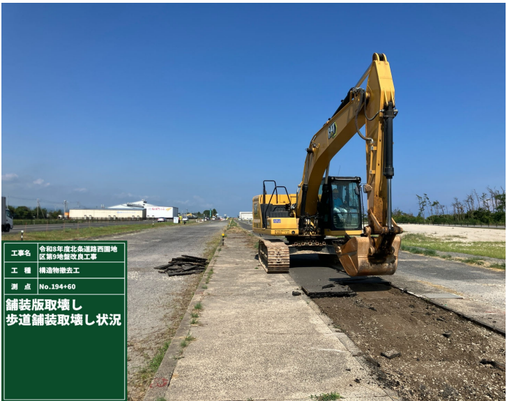
構造物撤去工 舗装版取壊し状況
