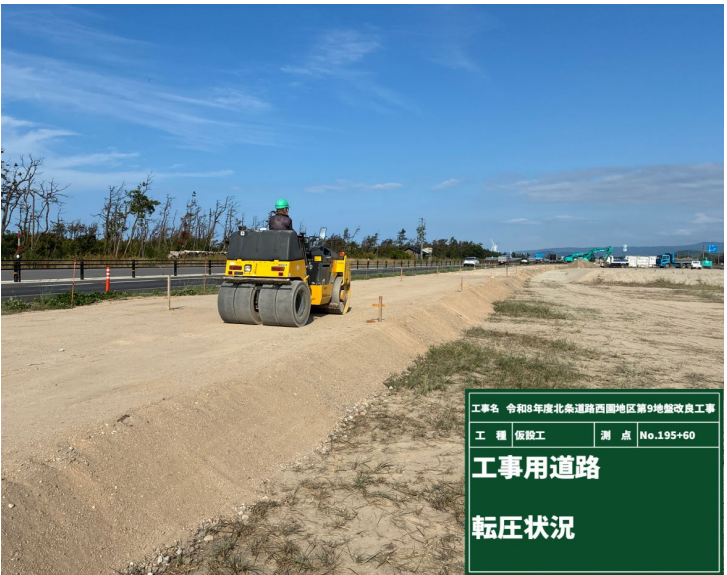
工事用道路工 盛土施工状況
