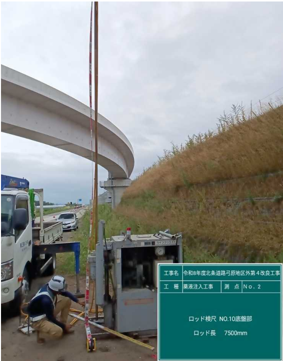
北側 固結工：薬液注入施工状況
