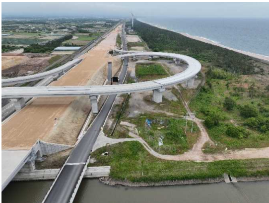
令和8年5月(着工前写真)
