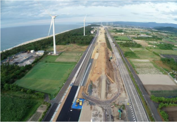
令和8年6月5日【着工前】
