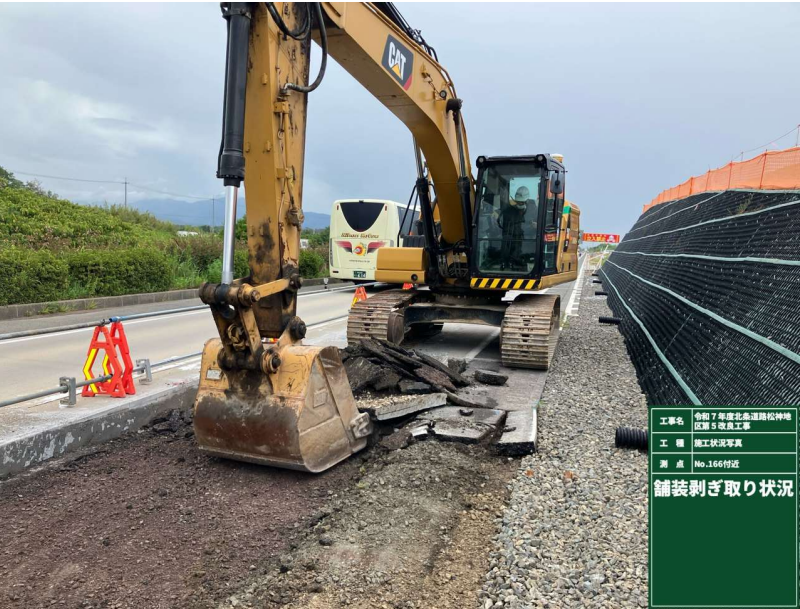
構造物撤去工
