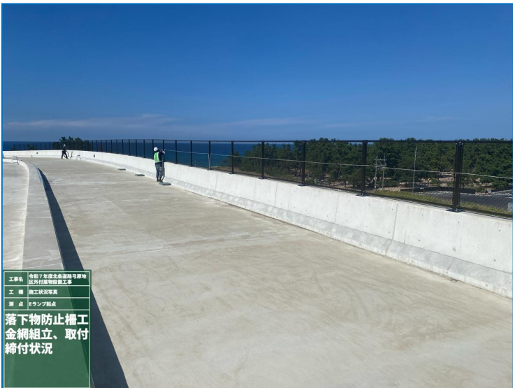
落下物防止柵工 取付状況
