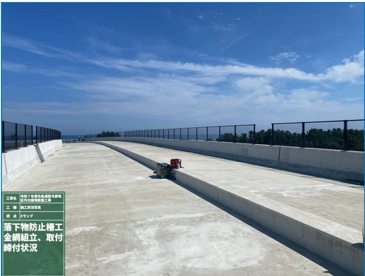
落下物防止柵工 取付状況
