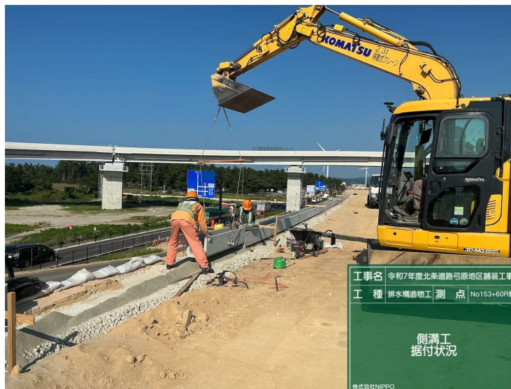
排水構造物工
