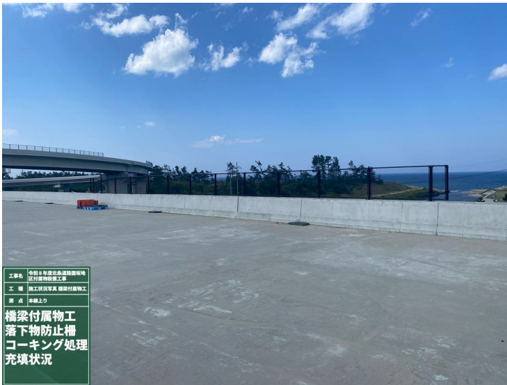
橋梁付属物工 落下物防止柵
