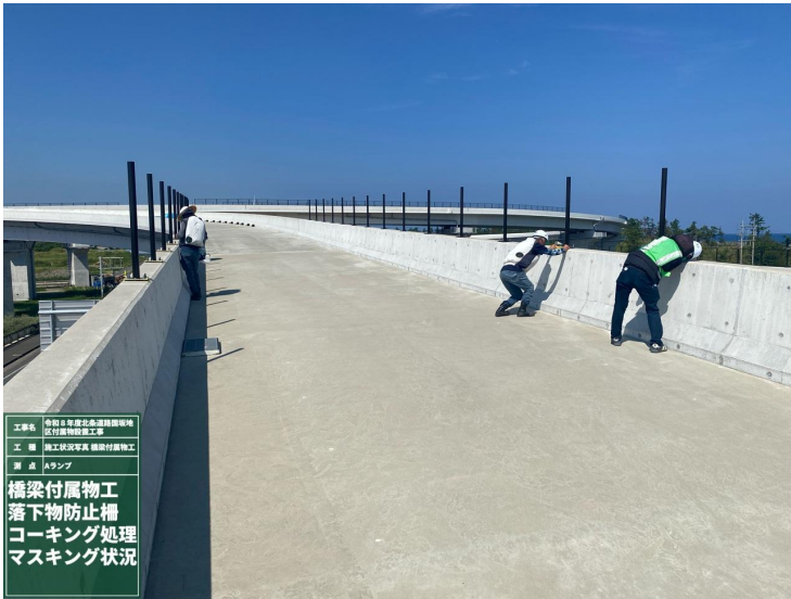
橋梁付属物工 落下物防止柵
