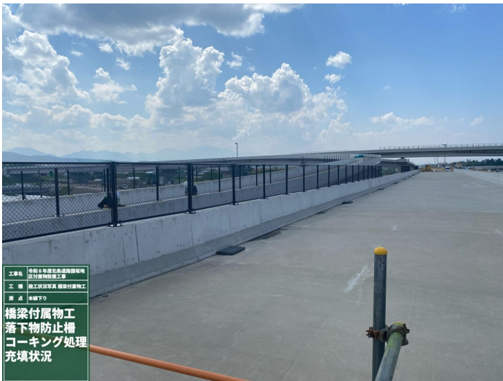
橋梁付属物工 落下物防止柵
