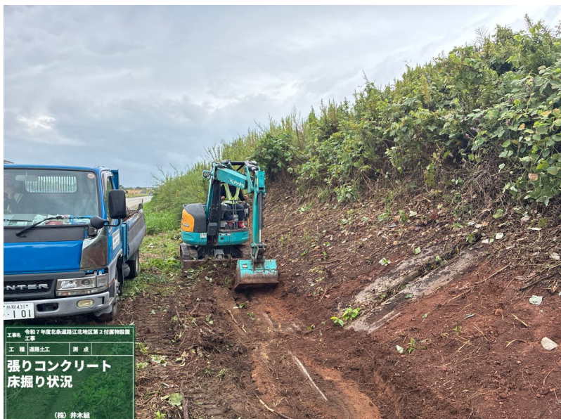
道路土工 張りコンクリート 床掘り状況 (国道側)
