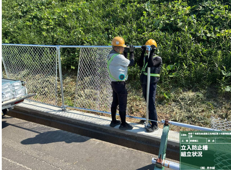
防護柵工 立入防止柵 組立状況 (町道側)
