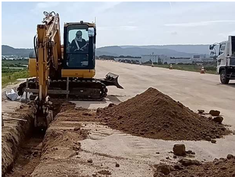
ケーブル配管工 床掘
